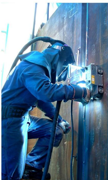
Pionowe spawanie doczołowe przy użyciu szyny prowadzącej
